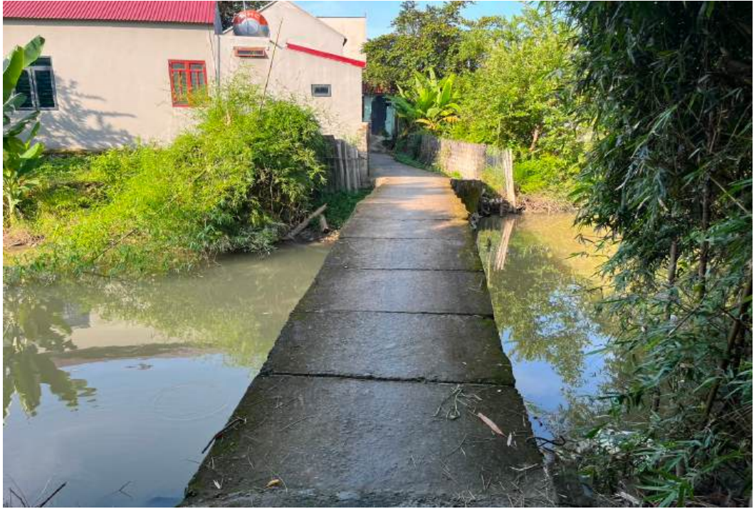
Hình 9. Cầu bắc qua sông Phồn vào ngõ (Nguồn: Tác giả chụp, tháng 3/2024)
